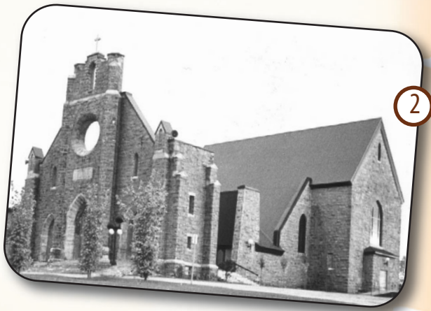
2- La nouvelle cathédrale de Mont-Laurier est érigée à l'intérieur des murs de granite de la cathédrale incendiée suivant les plans de l'architecte André Simon en 1984. (source archives diocèse : ph2chr76)
