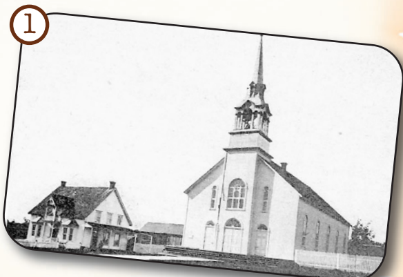
1- Dessinés par le curé Louis-Aurèle Corbeil, le presbytère et la belle église de Saint-Faustin sont érigés sur le lot de la Source en 1894. (source archives diocèse : ph1ch18)
